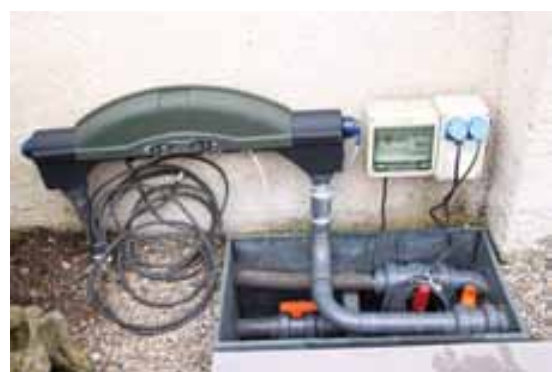
Pohled na UV-C lampu, čerpadlovou jímku a elektrickou skříň.
