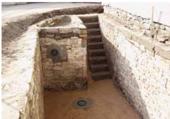
Starý krecht, opravený a zbavený stropu. Vytvarované rostlinné zóny a okraje jezírka, nainstalována dnová gula a příruba hladinového skimmeru. Sací potrubí je zapískováno. Jezírko je připraveno k pokládce geotextilie a hydroizolace.
